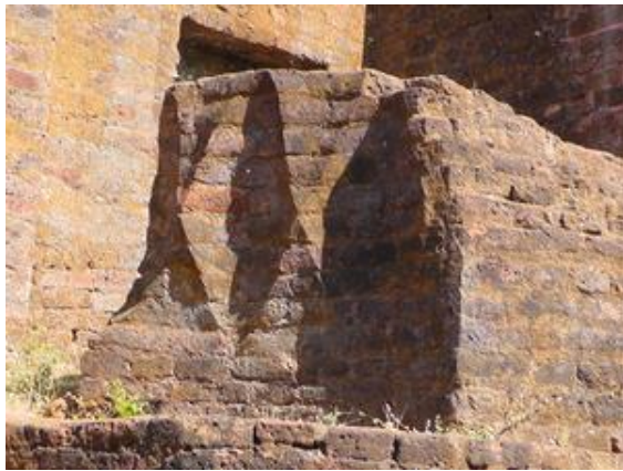
図 8 蓮弁模様レンガ積構造
